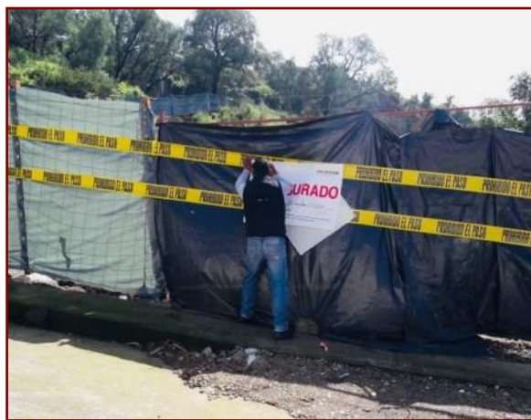
Figura 5. Clausura de predio en el municipio de Naucalpan, por no contar con autorización de impacto ambiental.
